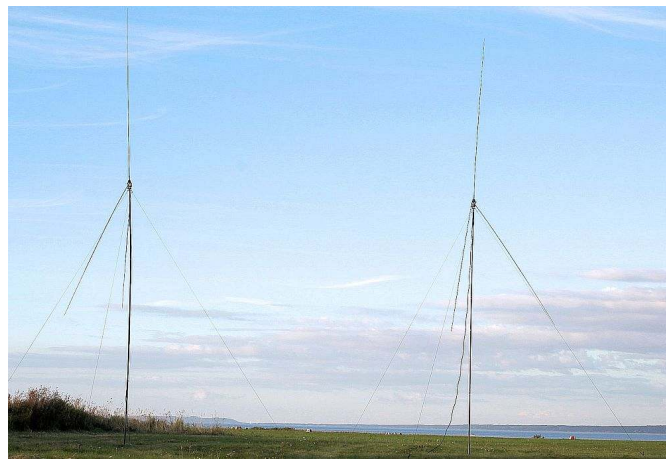
Resultatet av vedermödorna, två vertikaler med ett avstånd av en halv våglängd. Man ser att enbart två av de tre radialerna använts, detta för att lyckas få resonansen på 18,1 MHz.
