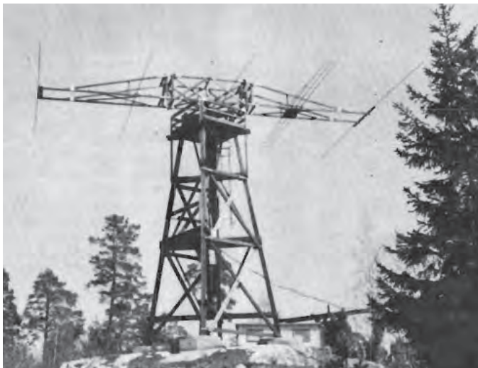
5 element horisontell yagi med 10 dB förstärkning för backskatter vid 16,5 MHz.
