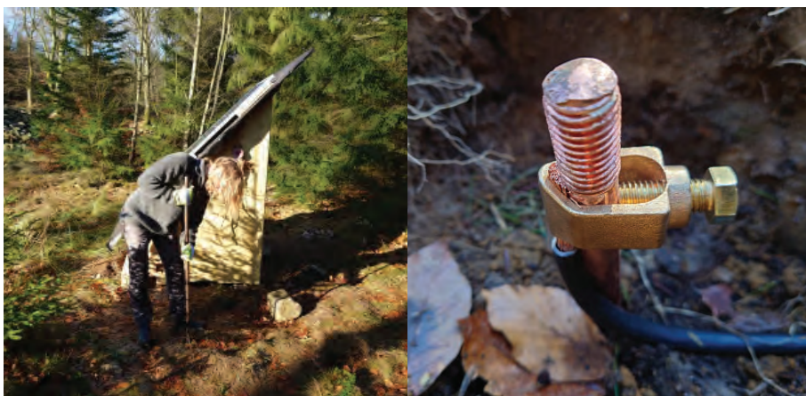
FIGUR 6: Med ett spett och en stor slägga installerar jag en jordtagsstång för åskskydd.
