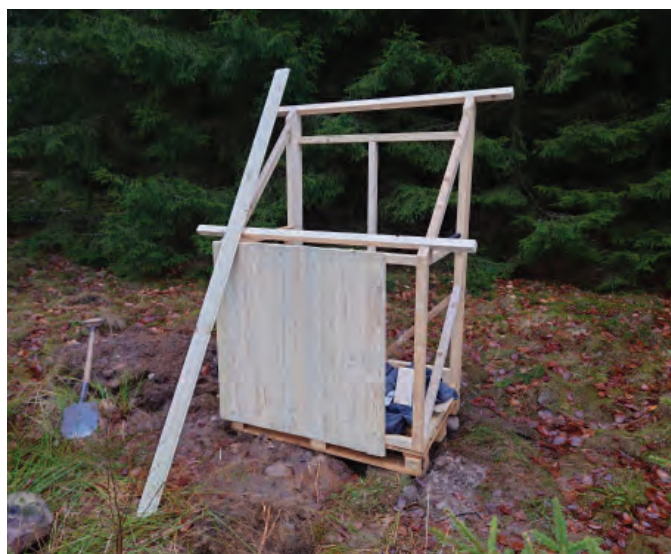
FIGUR 2: En enkel bod byggdes med en lastpall som bas. Bodens botten fungerar som väderskydd och som ställning för solcellerna.
