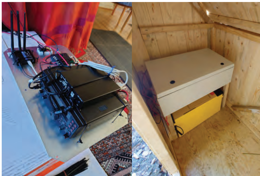
FIGUR 5: Till vänster: Elektronikpaketet består av en säkringsbox, 4G-modemet Teltonika RUT240, radion Yaesu FT-450, Remoterig, samt en Raspberry Pi Zero W. Till höger: Elektronikpaketet installerat i polykarbonatskåpet, de gula batterierna syns under.
