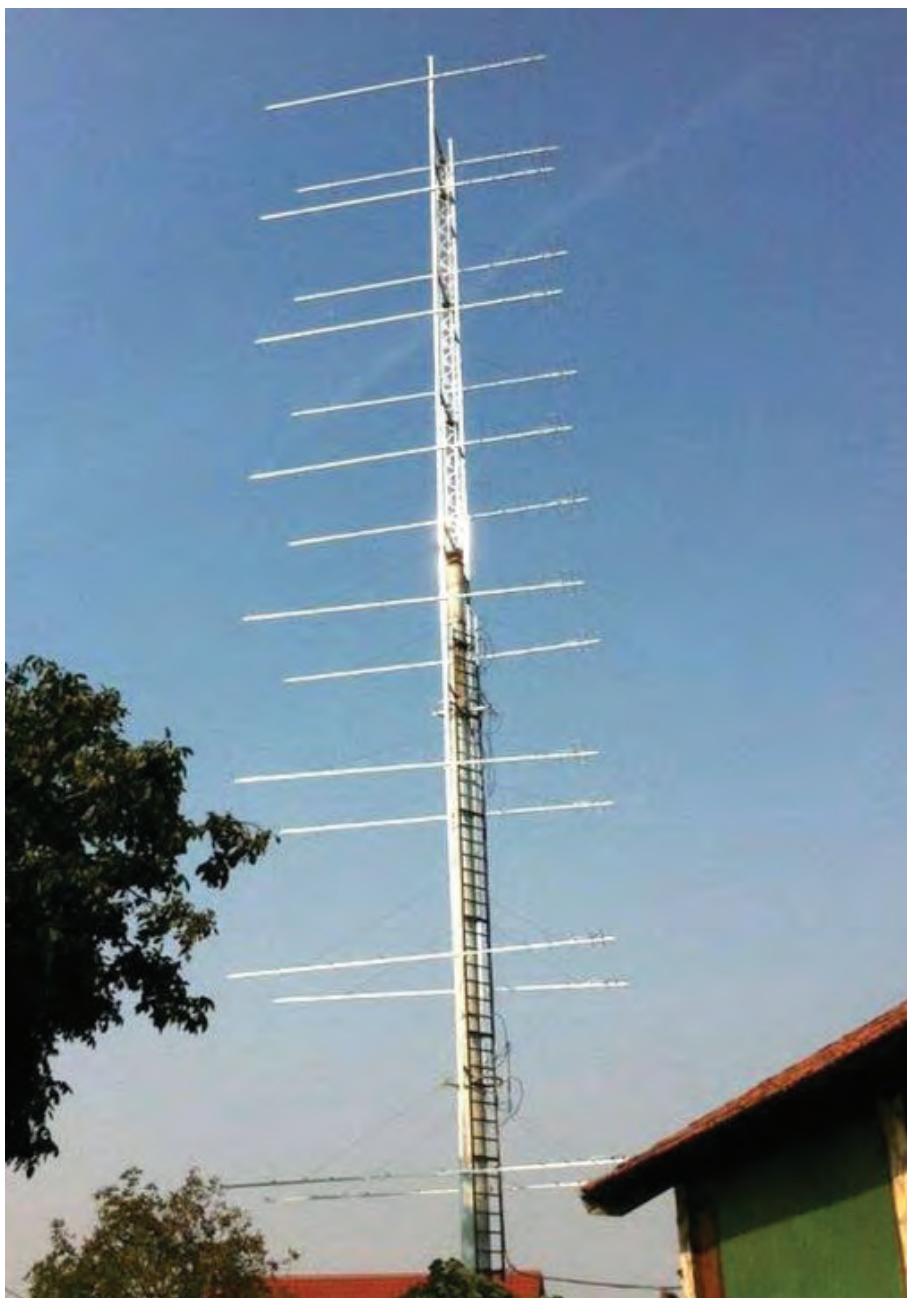
9A2AE ÄR JU OVANLIGT VÅLUTRUSTAD: 16x11 GOKSC LFA yagis.
