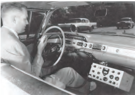
BILD 3: KWM-1 var företagets första sändtagare. Att placera den förhållandevis lilla radion i dåtidens stora amerikanska bilar var ingen match.
