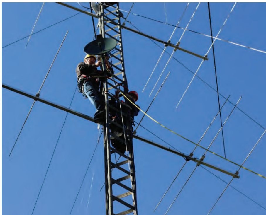
Peter SM2CEW och Bert SM2GCQ monterar fäste och fyrpaket i masten.
