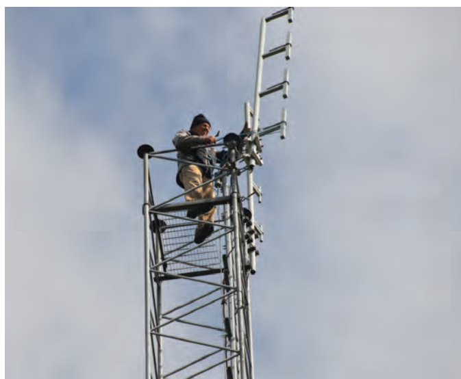
Enar SM7MQE använde en del av dagen till att justera de fyrstackade antennerna i toppen av den 42 meter höga Bödamasten. Foto: SM7DZV, Erik.
