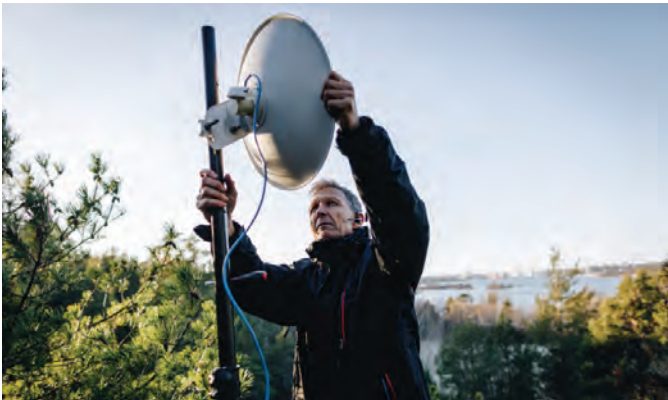
Michael Grimsland riktar in antennen mot stan. Lyckas signalen komma hit är det fri sikt sedan ut mot Ingarö som är nästa nod.
