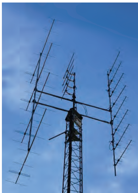
Masten med antenner på 2 m, 70 cm och 23 cm.
