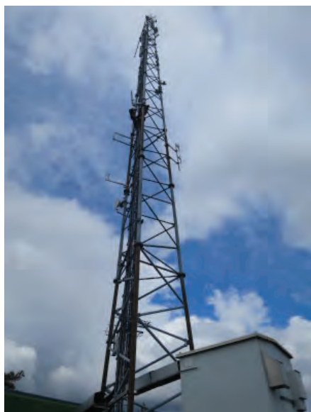
Montering av antenn.
