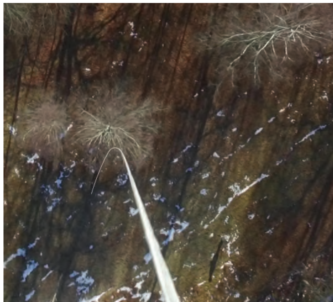
BILD 3: Hur det ser ut från drönaren när en lyftlina läggs ut över ett träd.
