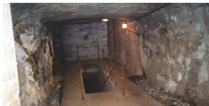
Ingång till radarstationen.
