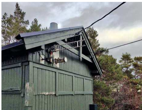
Hytta på Vardåsen med antenner for 23 og 13 cm beacon.
