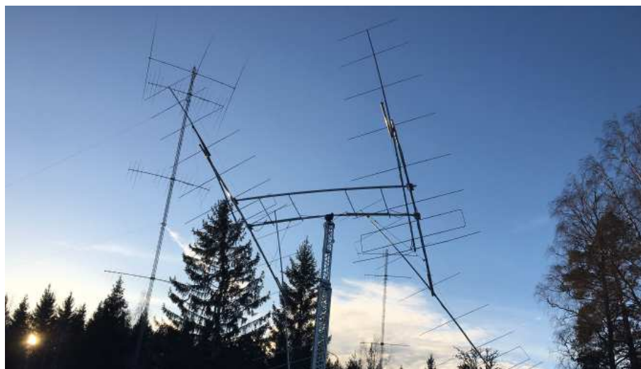
SM5AQD:s 6m antenner efter stormen.
