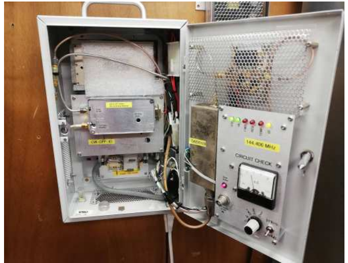
BILD 3, fyren är inbyggd i en före detta proppskåpslåda som räddats ur en container.
