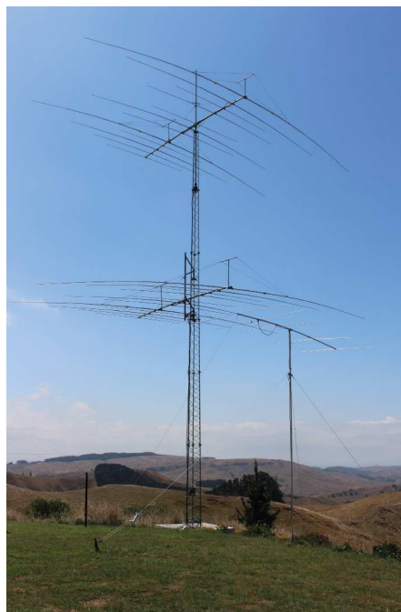
En av antennerna vid Kiwi-DX-Lodge, stackade 12 element 4 band yagis.
