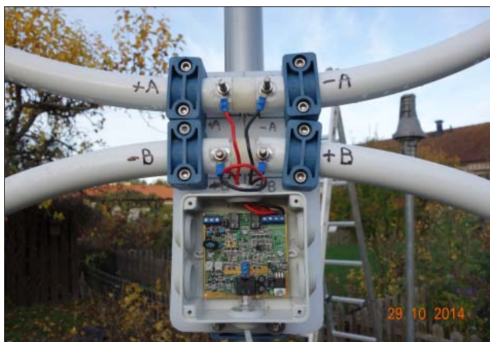
Bild 4 Hydraulslangklammer användes för montage.
