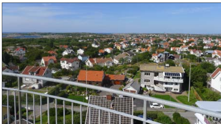
Hönö vattentorn mot Kungshamn.
