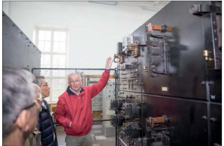
Ola Hernvall visar reläerna för den inkommande telegrafledningen.
