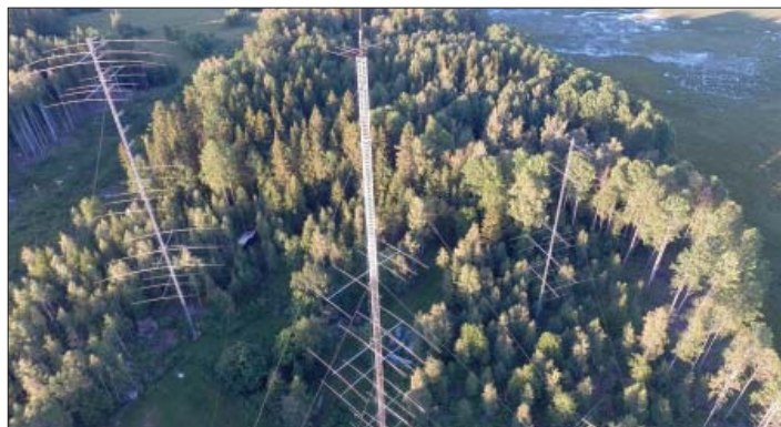
SK3W:s antenner, sedda från ovan. Masten i mitten av bilden är 68 meter hög och den till vänster 60 meter. Foto SM5TXT.
