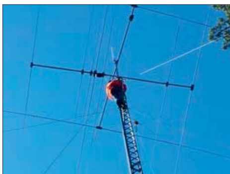
SM5AJV på väg upp för att fästa temporära stag.
