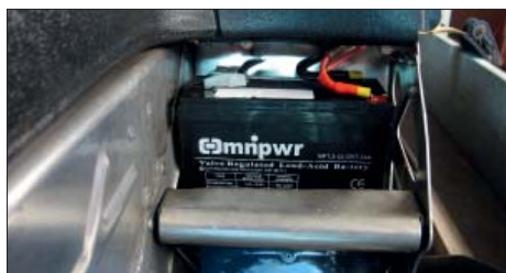
Batteriet monterades i fotstödet på snöskotern.
