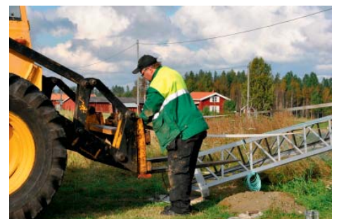
Förbereder lyftet av masten.
