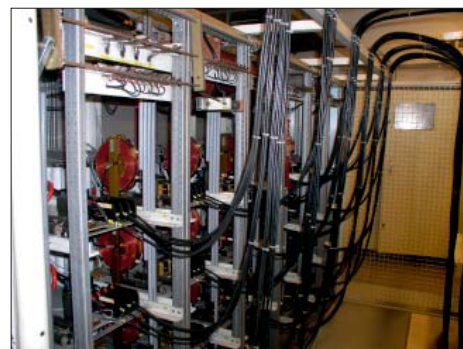
Modulatorn i 24 steg för kortvågssändarna. Matningspänning 40 kV.
