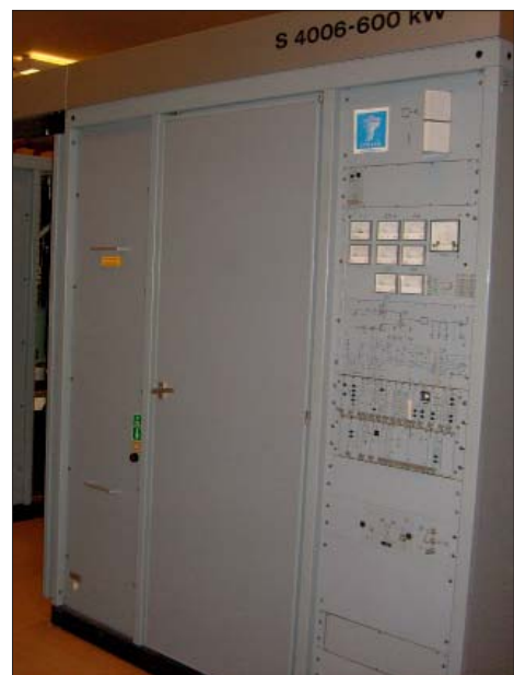
MV-sändaren på 600 kW i Sölvesborg. Fabrikatet är AEG/Telefunken och installerades 1985.
