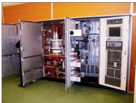
Öppna dörrar på en av kortvågssändarna från ABB/Thales i Hörby. Manöverpanel för manuell styrning till höger.
