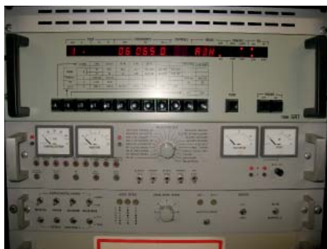
Ett par bilder av kortvägssändaren i Sala. Den består av en styrsändare TD90 från Svenska Standard Radio & Telefon (SRT f.d. ITT) som följs av ett linjärt slutsteg Collins 208U-10A som ger 10kW uteffekt. Mera information om utrustningen i Sala hittar du på: www.nybergsala.com Foto: Bernt Nyberg.
