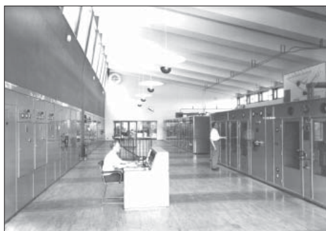
Sändarsalen 1952 med 2 x 100 kW KV-sändare t.h. och kontrollbordet i mitten. T.v diverse elkraftsutrustning.
