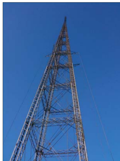
132 m hög fackverksmast i Sölvesborg. Masten utgör själva antennelementet.
