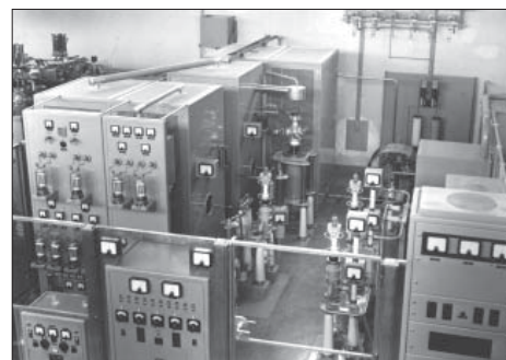
Standard Electric mellanvågssändare (100 kW) 1948 i Hörby. Foto: Teracom Hörby AM-station
