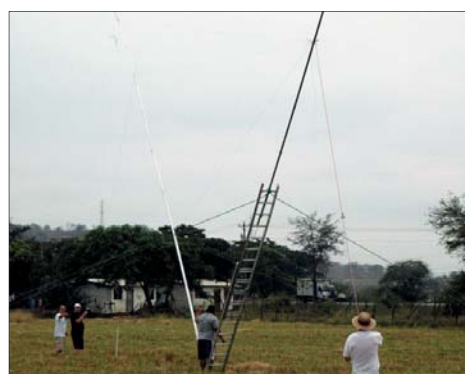
TITANEX antennen restes på ett risfält med utmärkt jordplan.
