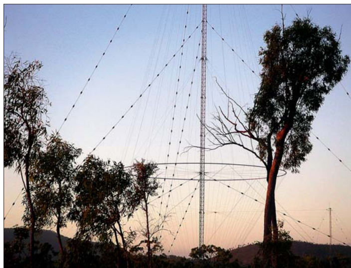
Figur 5, en av de två vertikala antennerna, avsedda för anrop och uppkoppling.
