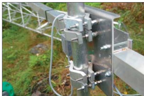
Bom (80 x 80mm) och fästet till masten.
