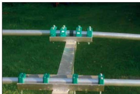
Vi använde oss av fästblock, som används inom industrin för att fästa t.ex. högtrycksslangar, för att montera elementen.
