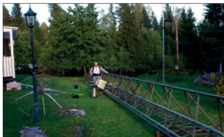
Masten med skenor, typ som används för stora portar, samt släde.
