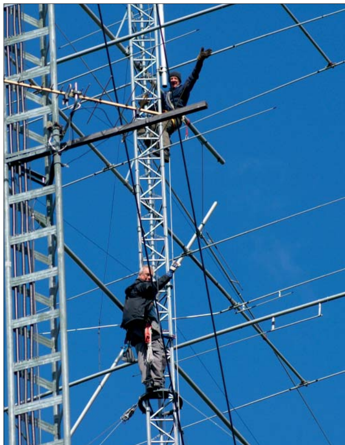
Marigt på hög nivå. QTC-redaktören som står på stageringen 32 m upp får hjälp av SM0GNS, Peder att fixa 5-elementaren för 14 MHz.
