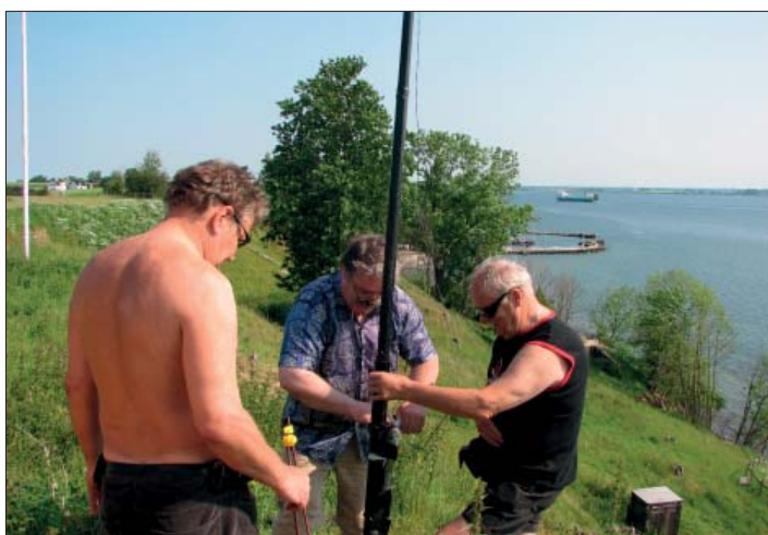
Antennen, en inverterad L, reses. I bakgrunden skimtar man Bäckvikens hamn.
