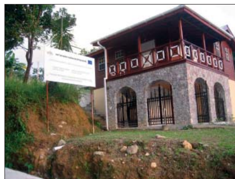
Här är byns datacenter byggd av EU-medel. Det fungerade som ett internetcafe utan cafedel! Många hade fungerande internetuppkopplingar i byn. Så hyfsad bra infrastruktur trots terrängen!
