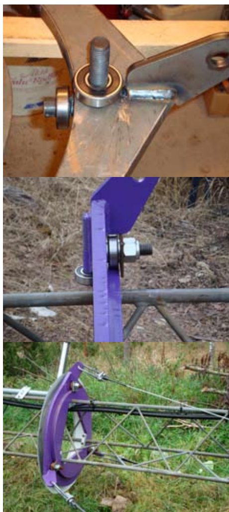
Stödlager för masten.
