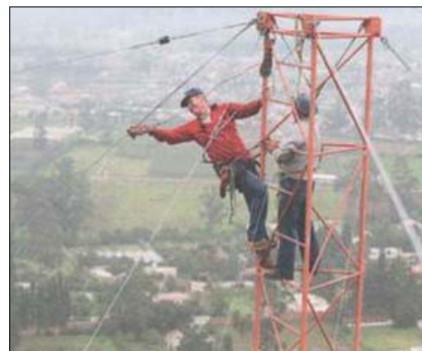
Antenner i Pifo, Ecuador monteras ned och åter används på andra platser..
