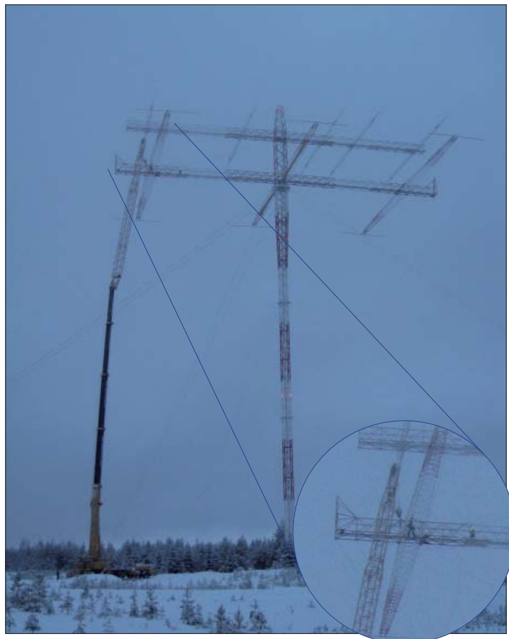
Radio Arcala OH8X 5 elements Yagi för 80 överst och undertill byggs 3 element för 160 meter! Bilden är lite kornig, men i den infällda bilden kan två personer skönjas, en har gul jacka och båda två står inuti bommen. Foto: OH8NC
