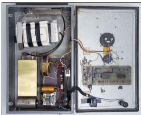
Hela innanmätet. Osc sitter lite på sned (inte likt ESG). Detta skall rättas till vid nästa översyn. PA:t längst upp. Foto: SM6JJX Lennart Benson.
