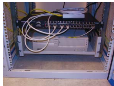
VoIP mixer (Microbit Microswitch 1190) och streaming server.
