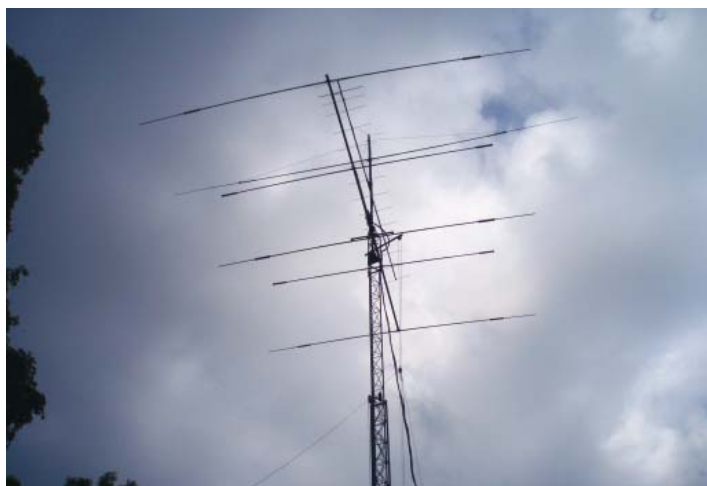
Versatower med 5 el beam, WARC-antenn och dipoler
