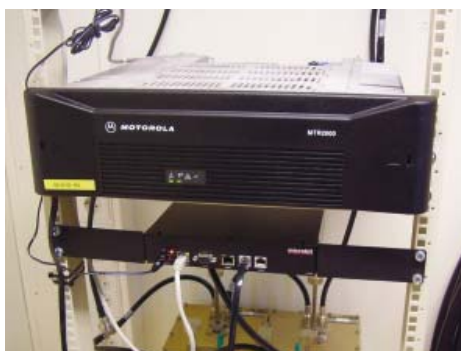
Repeater RV60(R6) i Överkalix. Motorola MTR2000, VoIP-Router "IP-Tube 1393" och duplexfilter från Kathrein.
