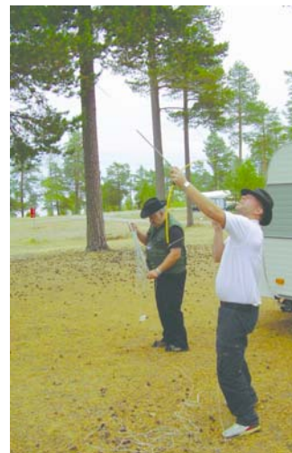
SM2YIP och SM2OAN leker indian & cowboy'sar. Efter några försök så fanns en dipol uppe, 2x19 på 80meter, en dipol på 20meter och en bredband-dipol 80-10meter. (Foto: SM2K)
