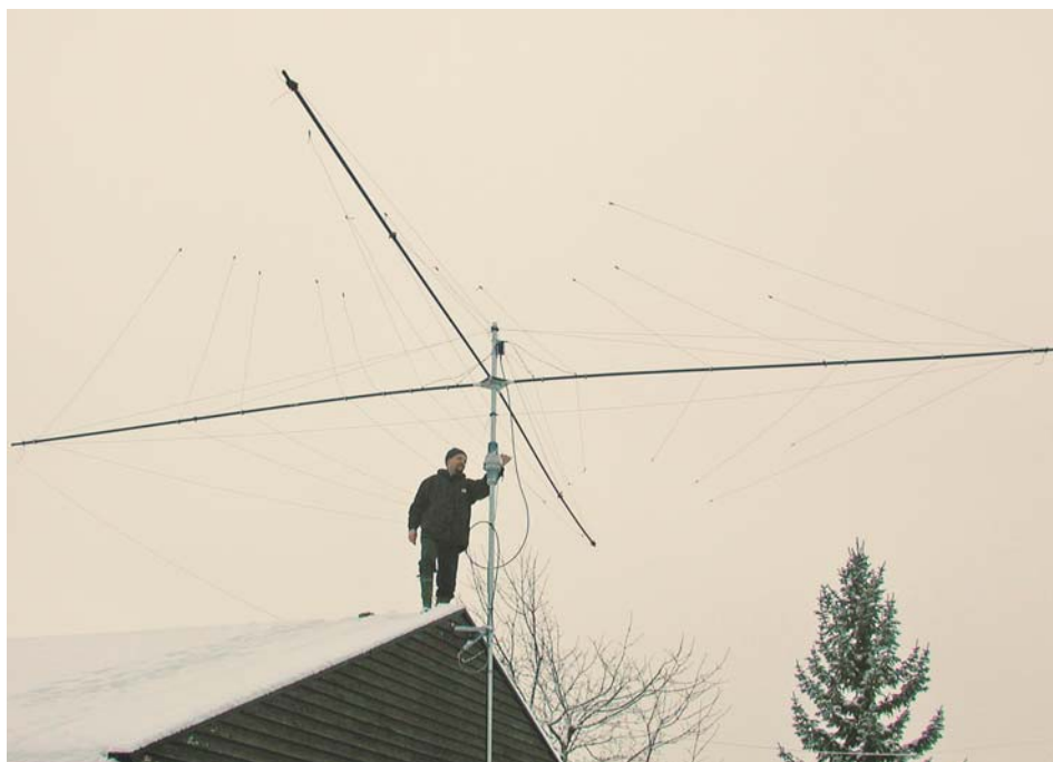
När det är myggfritt, kallt och snöigt är det som alla vet lämpligt antennbyggarväder. Här står SMOJZT på taket efter att ha halkat upp den egenbyggda Spiderbeam-antennen. Nu skall här bli DX-körande! Foto: SMOGDB Mats
