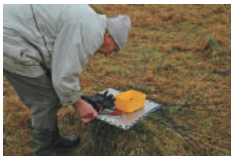
60 st radialer à 42 meter skall monteras vid varje element för 160 meter.
