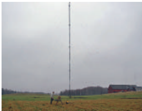
42 metersmasten med 4-square för 160 meter.
